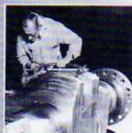
Mit Schutzpaste geschützte Flansch-Abdichtung
